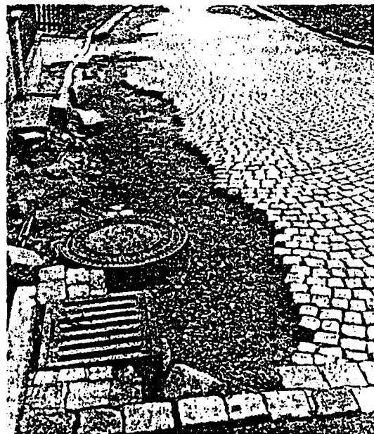
Zerstörte Straßen: So wie im Unteranger, wo die Pflastersteine weggespült wurden, sah es gestern an vielen Stellen in Marktschoragast und Himmelkron aus. Foto: Jäckel
